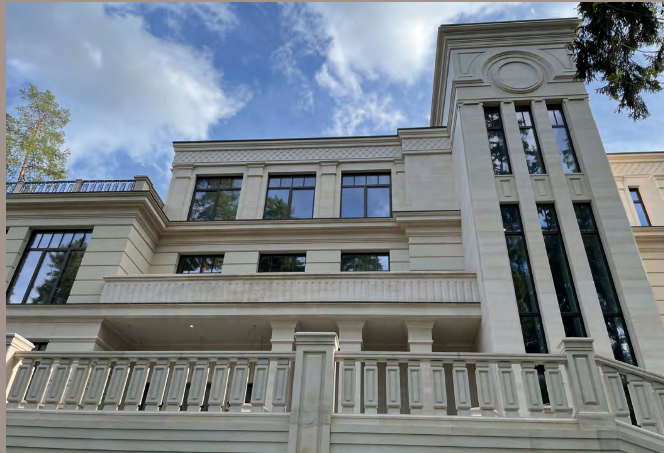
ЧАСТНАЯ РЕЗИДЕНЦИЯ. ПОДМОСКОВЬЕ. ПОСЕЛОК: «ЖУКОВКА». АРХИТЕКТОР: ОЛЕГ КЛОДТ (НАТУРАЛЬНЫЙ ИЗВЕСТНЯК И ГРАНИТ)
