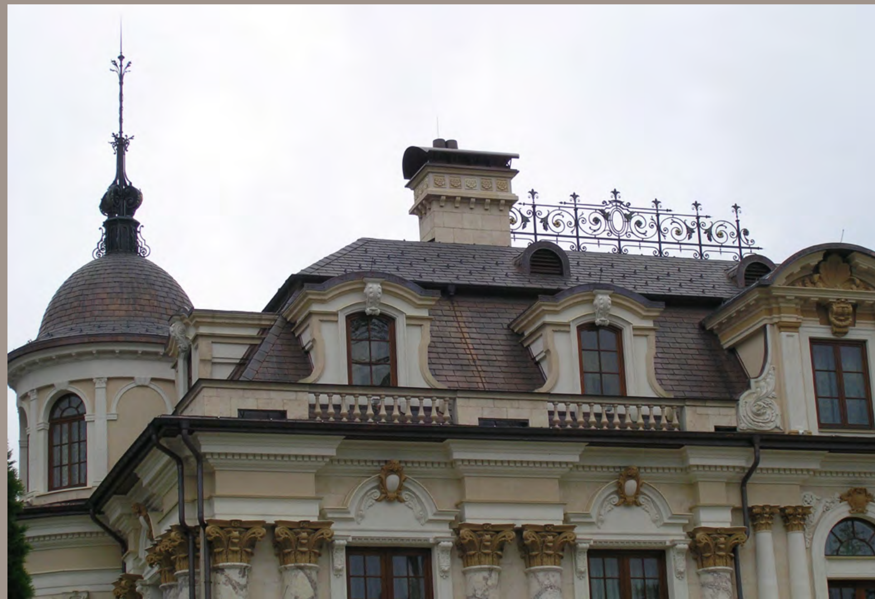
ПРИМЕРЫ РАБОТ ПО КРОВЛЕ
